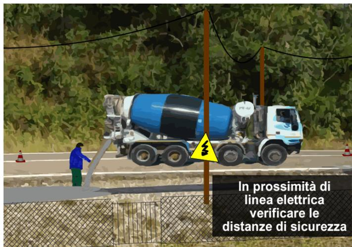
La sorveglianza per garantire la sicurezza di un operatore a distanze dalle parti in tensione inferiori a quelle di sicurezza, è praticabile e accettabile per attività limitate e circoscritte nei fini e nei mezzi utilizzati, come quelle ipotizzate nell'applicazione dell'art. 83, mentre è impraticabile e inaccettabile in un cantiere.
